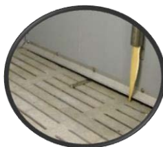
2. Vide sous les cloisons recouvert d'une cornière en inox
